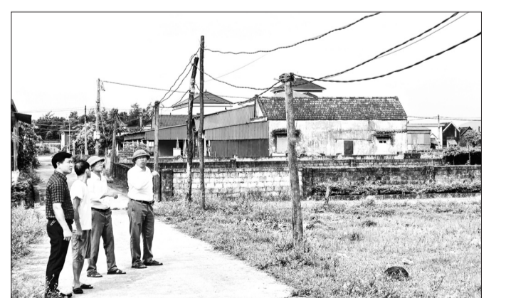
Lãnh đạo xã Kỳ Khang kiểm tra đường điện hạ thế 0,4 kV xuống cấp trên địa bàn thôn Trung Tân.
