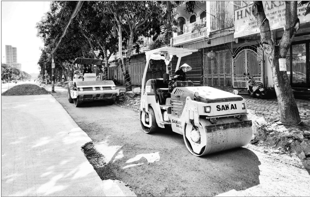
Đơn vị thi công tăng tốc tiến độ dự án nâng cấp vỉa hè và hạ tầng kỹ thuật đường Nguyễn Du (đoạn từ đường Trần Phú đến đường Nguyễn Công Trứ).
