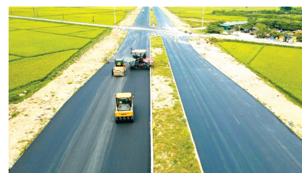
Công ty CP Tập đoàn Thành Huy huy động máy móc, nhân lực triển khai thi công thảm bê tông nhựa mặt đường đoạn tuyến Km 4+740 - Km 5+959.
